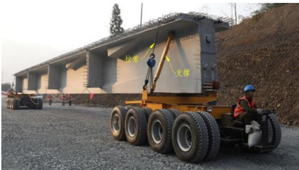
图 12 梁板支撑方式示意图
